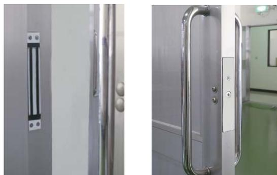
嵌入式室內電磁鎖是針對側拉式滑動門設計的，電磁鎖嵌入在門框內；吸附板嵌入在門扇內，外部看不到任何配件，非常安全與美觀，也不會影響門扇的結構與強度。型號10000和10000ST 電磁鎖提供600磅吸力，10003F 迷你型電磁鎖採用不鏽鋼外殼與百分之百防水處理，非常適合安裝在戶外或是有危險易燃氣體的密閉空間，操作的時候不會有火花發生。
